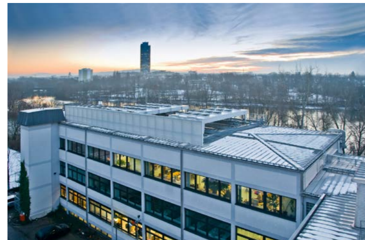
Dienststelle Nürnberg, Voigtländerstraße (Rechenzentrum Nord)
