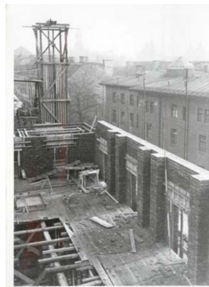
Im Bau befindlicher Sophiensaal
